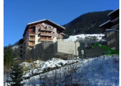
**Toiture/ Faîtage** : Les faîtages sont perpendiculaires aux voiries et un pignon forme la façade principale. Les toitures sont de type bac acier sauf pour l'Hôtel Viallet, revêtu de tuile de terre cuite.
