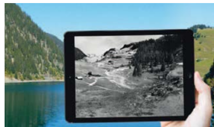
Vue avant le barrage
