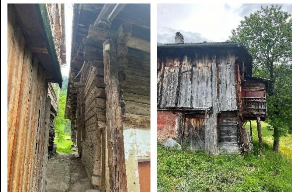
Photo 20 Façade Ouest et Nord
